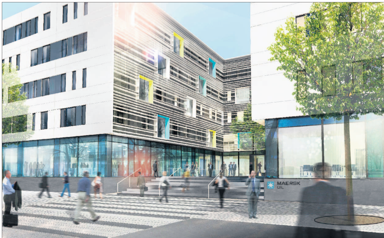
I dag er Maersk Oil fordelt på fire adresser på Esbjerg Havn. Når KPC Byg opfører et markant nyt kontorhus til Maersk Oil i Esbjerg samles medarbejderne under samme tag. Illustration: Årstiderne Arkitekter
